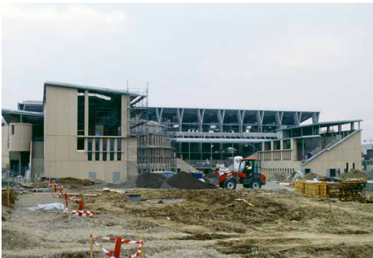
Construction de la bibliothèque
